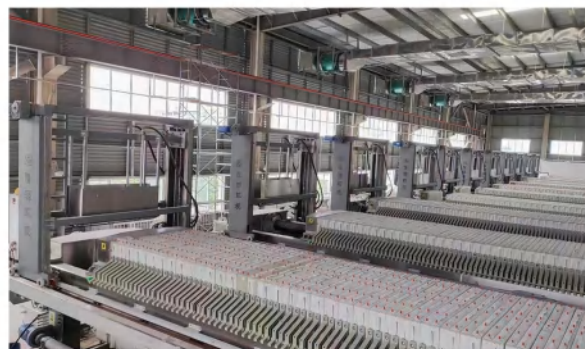
新能源10万吨磷酸铁锂项目
