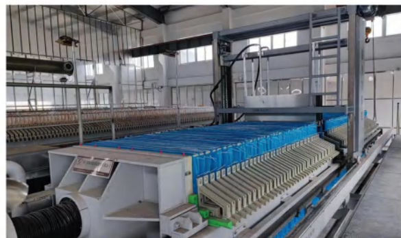
光大水务5万吨市政污水EPC项目
