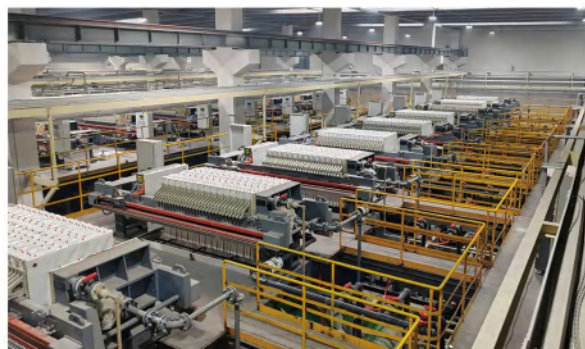
2万吨多晶硅EPC项目
