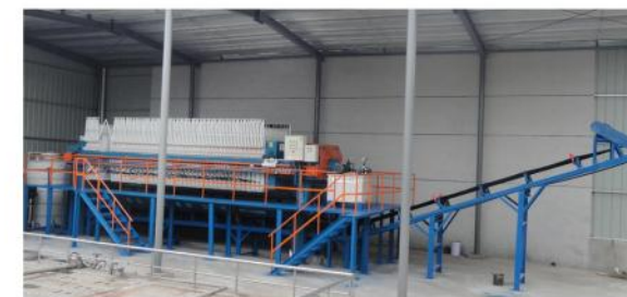
临安某污水处理厂（日处理规模20000T/D）
