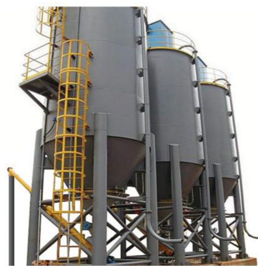
石灰投加系统 Lime dosing systems
